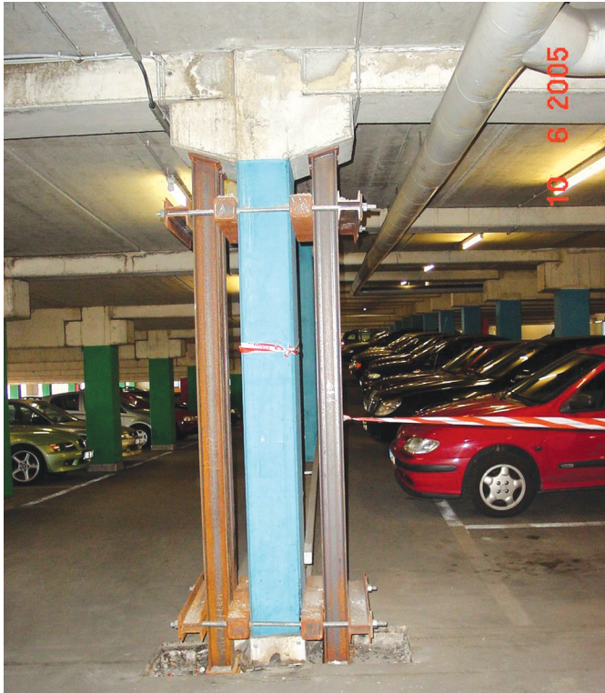
Bild 8. Abfangungen in allen Etagen
